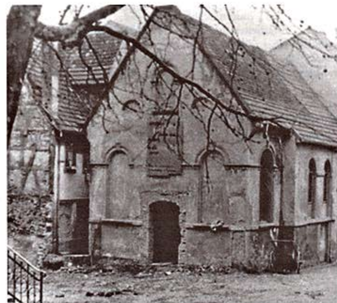
Die ehemalige Synagoge in Wiesloch. Sie wurde in der Reichskristallnacht 1938 vollkommen zerstört. Foto: repro/aot
